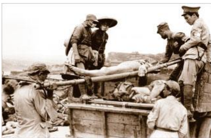
▲圖 2-29 重慶防空洞慘案。1941 年 6 月 5 日，重慶市中心大隧道防空洞，因擁擠發生窒息慘案，死者 2 萬人。
