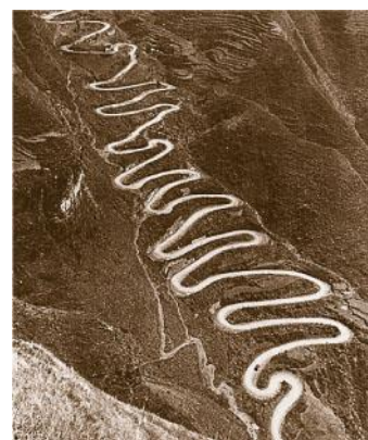
▲圖 2-26 滇緬公路。滇緬公路路長 900 餘公里，動員 15 萬人，經 7 個月迅速通車。工程在崇山峻嶺中，徒手進行，以竹籃運土石、以竹管填裝火藥炸山。數千民工死於工傷或瘧疾。
